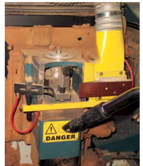
Menuiserie, maintenance de l'équipement de perçage.
